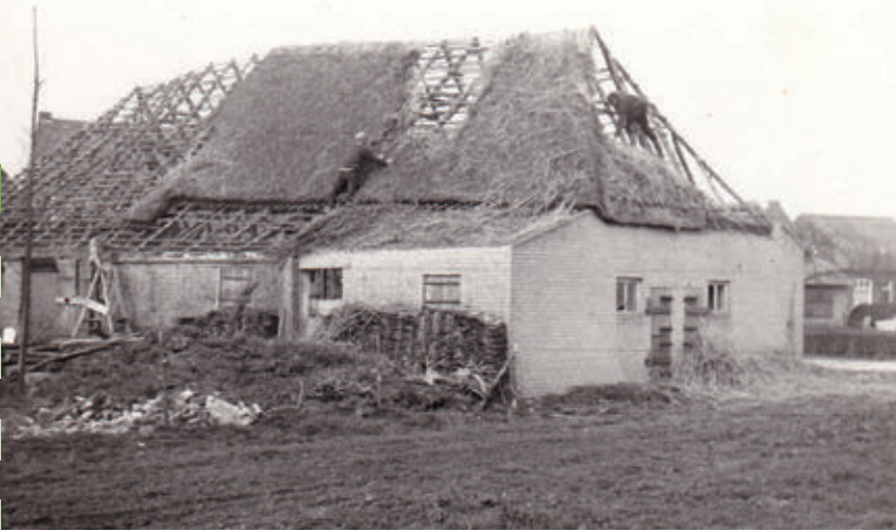
De schuur bij De Blauwe Kei tijdens de sloop in 1971 (collectie Jan Timmers)
