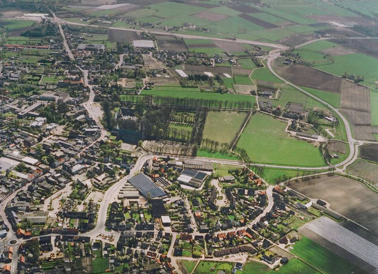
Luchtfoto voor de sloop van textielfabriek Raaymakers. Onderaan de voormalige domeinhof met De Haag als begrenzing, doorsneden door de Komweg. Verder naar boven het huidige kasteelcomplex van Gemert.
