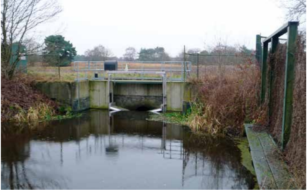
De stuw op de plaats waar het Defensiekanaal en het Koordekanaal bij elkaar komen ter hoogte van de Hazehut.
