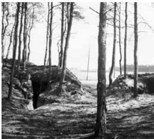
Langs het Koordekanaal werden veldversterkingen ingericht, zoals hier in Elsendorp
