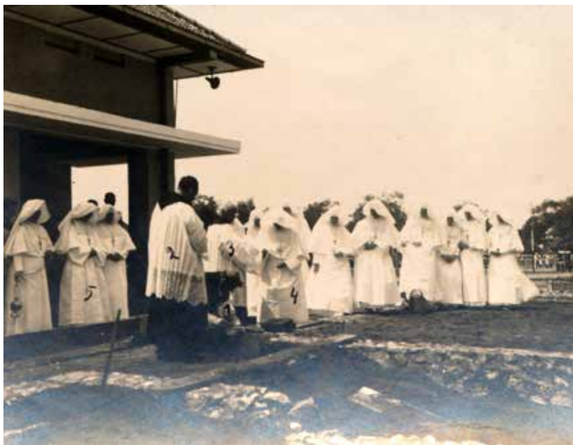
Zuster Martha (5) is bij de eerste steenlegging door Mgr. Albers (2)
