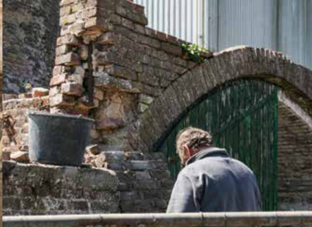
Restauratie van de invaartpoort.
