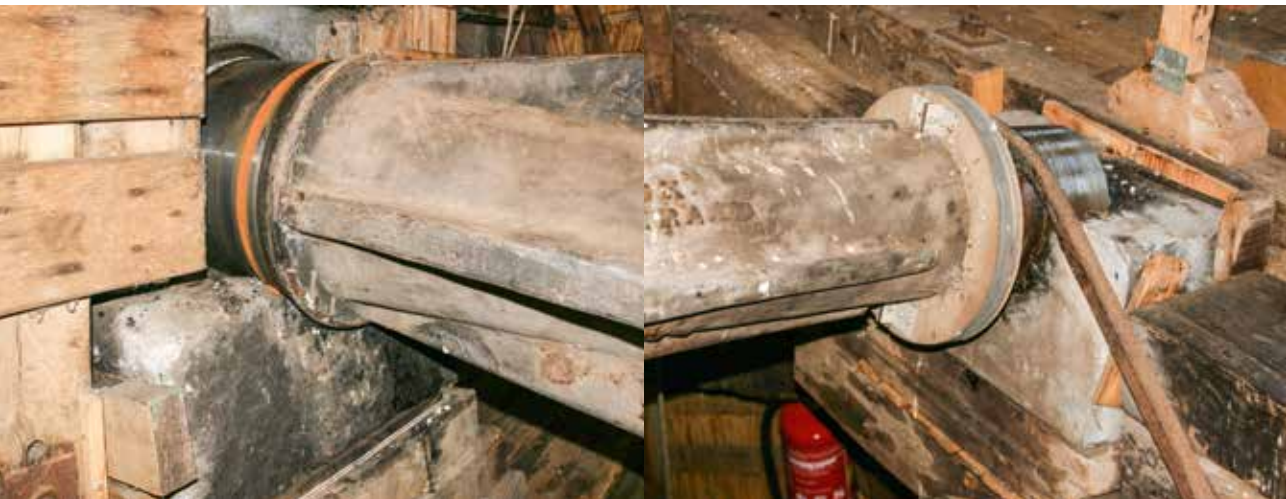
De gietijzeren molenas, gemerkt met de namen van heemraad en polderschout, draaiend in de baansteen en de pensteen.
