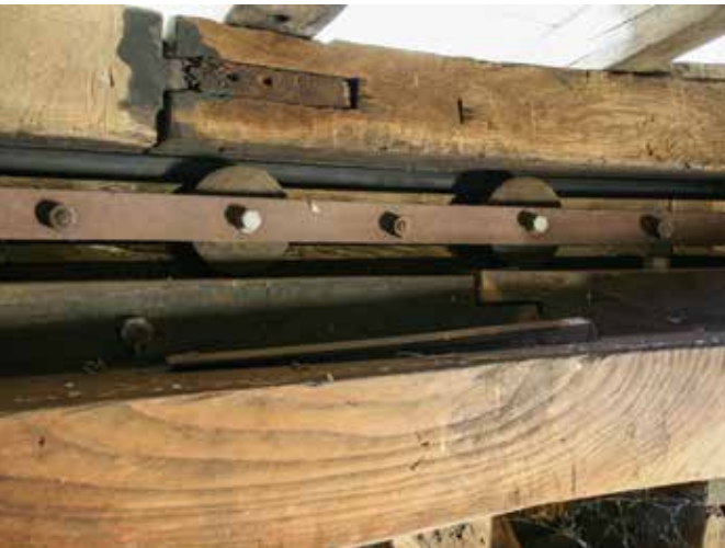
Rollager dat het draaien van de molenkap mogelijk maakt
