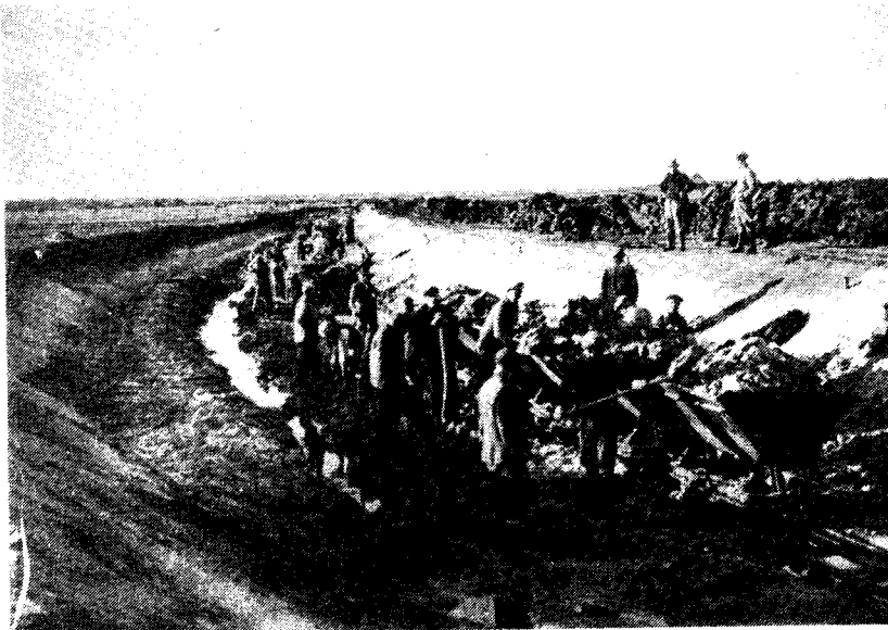
Het graven van het Koordekanaal (foto-archief Sectie Krijgsgeschiedenis Den Haag)
