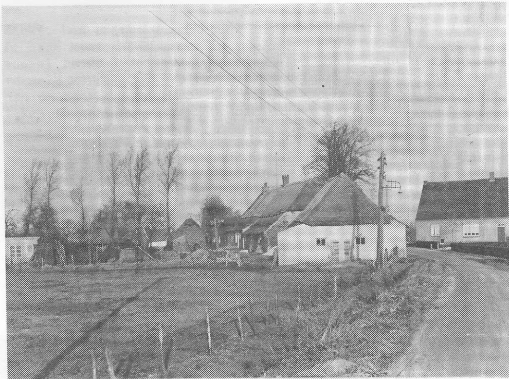
Gezicht op achterkant schuur en de westelijke achtergevel van de boerderij. Links van het huis is het bakhuis zichtbaar. (foto 1964).
