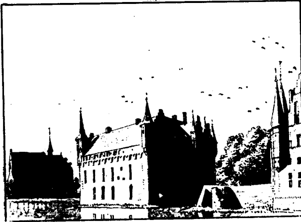
Afb. 7. Het kasteel van Gemert in 1730 (A. de Haen). Vanuit het zuidwesten. Hierop is de rijk gedetail- leerde voorzijde van de hoofdburcht goed zichtbaar.
