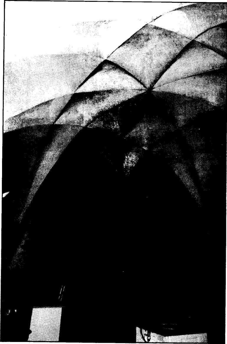
Afb. 5c. Bakstenen gotisch gewelf. Kelderverdieping Kasteel van Gemert.
