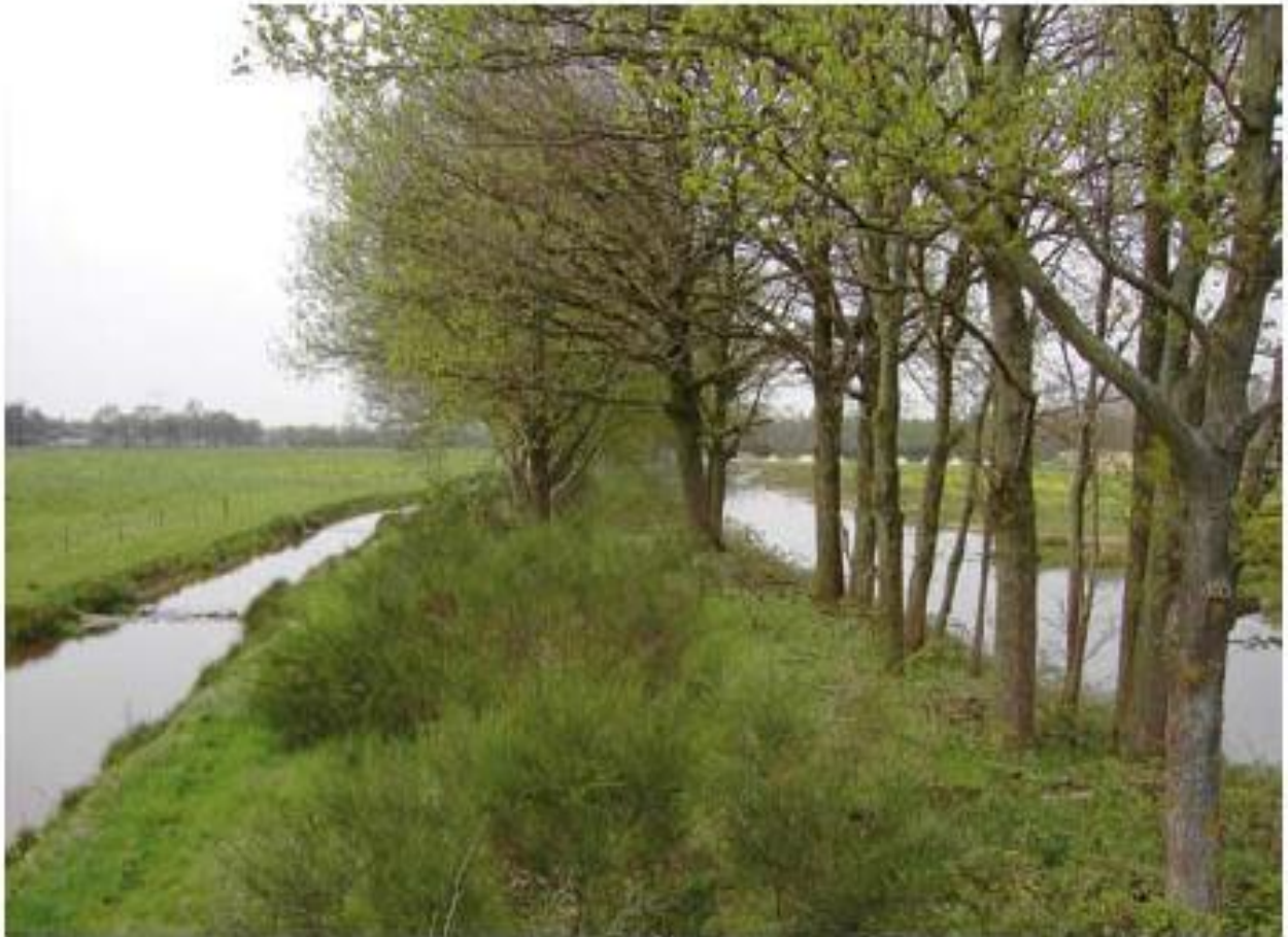
De herstelde dubbele loop na aanleg van de ecologische verbindingzone langs de Snelle Loop. Rechts de Snelle Loop, voorzien van flauwe oevers; links de opnieuw gegraven "vistrap" aan de Laarbeekse kant van de landweer en tussen de twee waterlopen de middeleeuwse wal. (foto auteur).
