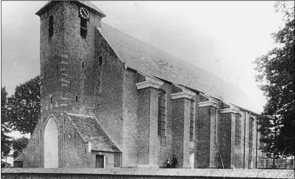
De kerk van voor 1897 met het oude vijftiende eeuwse torentje met aan weerszijden de zogenaamde aanbouwsels. Rechts naast de toren was dus een vertrek dat middels de getraliede opening in verbinding stond met het interieur van de kerk. Tussen de tweede en derde steunbeer is ook nog duidelijk te zien de zij-ingang met erboven de wapenstein van de Duitse Orde.
