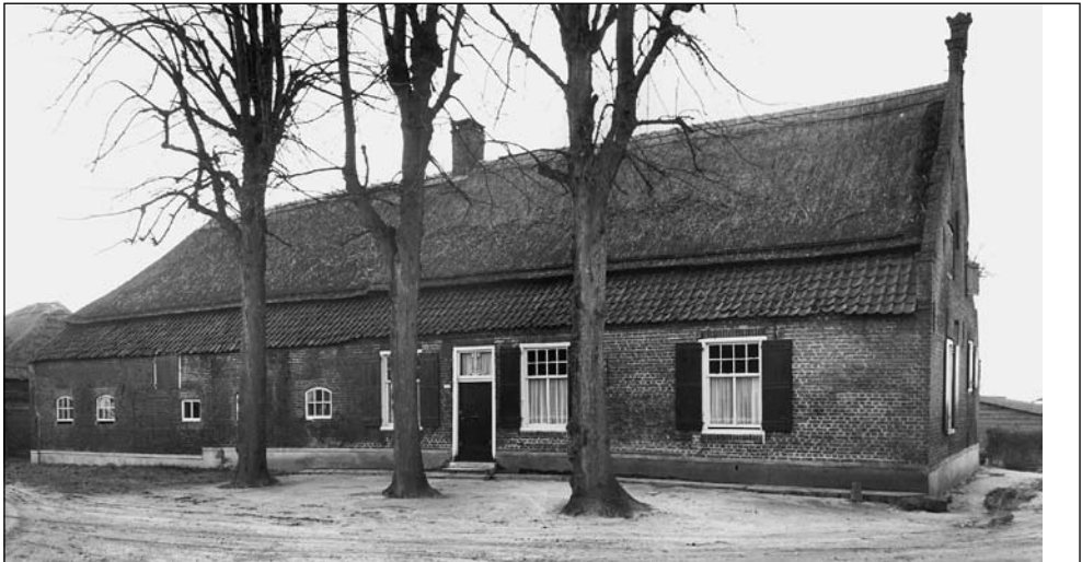
De Blauwe Kei. De gelijkenis met boerderij Smulders (zie pag.1) is opvallend, overigens niet alleen aan de buitenkant.
