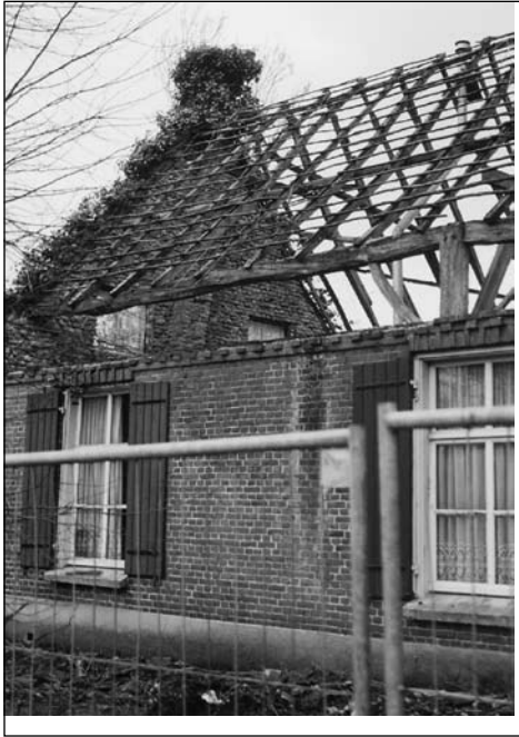
De grote afstand tussen gebint 5 en de zuidelijke topgevel is goed zichtbaar. Om deze afstand te overbruggen zou je een extra gebint verwachten. (foto J. Timmers)
