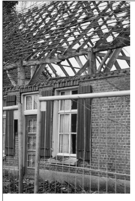
Het pand gedeeltelijk gesloopt. Het bovenste deel van de gebinten 4 en 5 zijn boven de muur zichtbaar. Tussen deze gebinten is de las in de worm goed zichtbaar. Ook de wijze waarop de daksporen op de worm zijn geplaatst is te zien. (foto J. Timmers)
