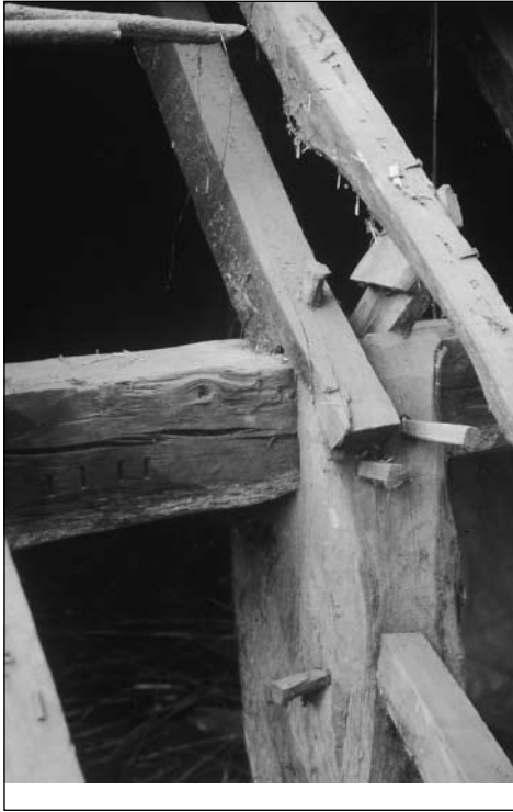
De bovenzijde van gebinstijl 4 van De Blauwe Kei. De verbinding van de dakspoor met de worm middels een houten pen is duidelijk. Links op de worm het telmerk: 4 met een rechte beitel ingekapte tekens, die gebint 4 aangeeft. Aan de andere zijde van het gebint zijn de merken met een ronde beitel ingekapt, waardoor het verschil tussen linker en rechterzijde aangegeven kon worden. De telmerken bij boerderij Smulders waren identiek. (foto J. Timmers)
