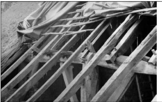
De dakconstructie ter hoogte van gebint 4. De daksporen rusten op de worm en zijn met houten pennen vastgezet. Daaroverheen en verder naar beneden lopen de sporen boven de zijbeuk, die op de buitenmuur rusten. Deze laatste worden middels houten klossen op de worm ondersteund. De foto is van De Blauwe Kei; bij boerderij Smulders was de constructie identiek. (foto J. Timmers)
