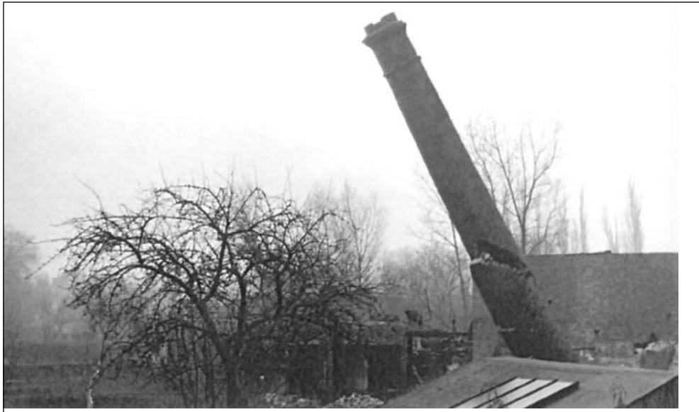
Kort na de sloop van het woonhuis en de fabriek in het voorjaar van 1967 werd ook de schoorsteen opgeblazen. Noud Rooderkerken sr. maakte deze foto juist op het moment dat de pijp in tweeën brak. (Foto: Noud Rooderkerken sr.)
