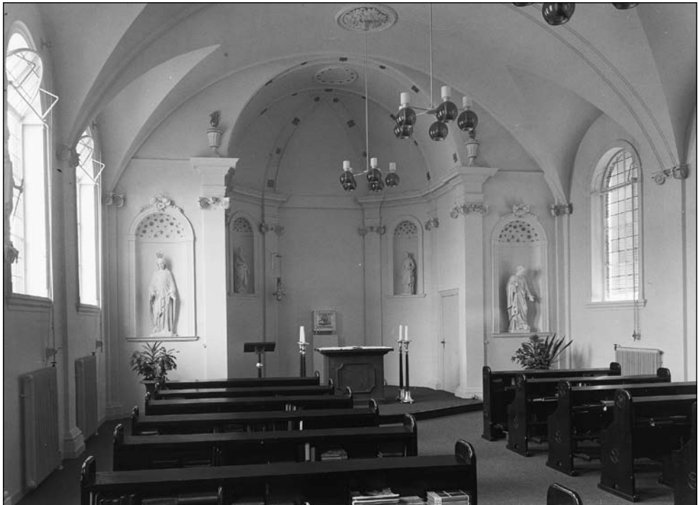
Kapelinterieur 1967. Herkomst foto: Rijksdienst Monumentenzorg Zeist
