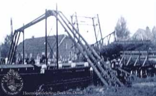
Een foto van hoe de pipeline naast de Beekse Brug de Zuid-Willemsvaart passeert. (met dank aan de heemkundekring van Beek en Donk)
