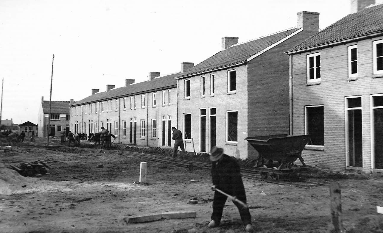
Bouw Berglaren, november 1951.
