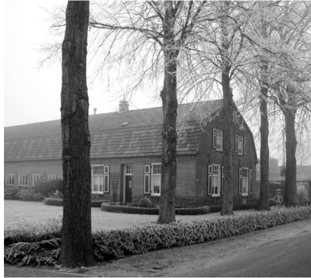
Wilhelminahoeve (De Bleek 32), bouwjaar 1928. Geen staldeuren of schuurdeuren in de lange gevel.
