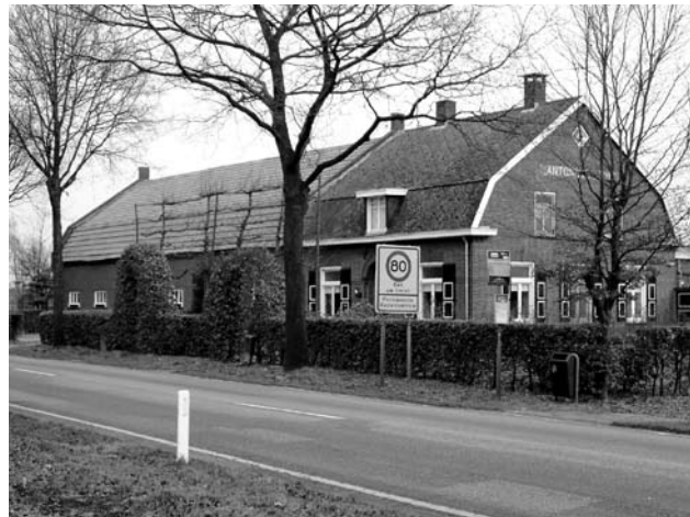
Antoniushoeve, Boekelseweg 25, gebouwd in 1933. Doorgetrokken brandmuur tussen woon- en stalgedeelte, mansardekap met eternit shingles. Na een brand werd het bedrijfsgedeelte gedekt met pannen.
