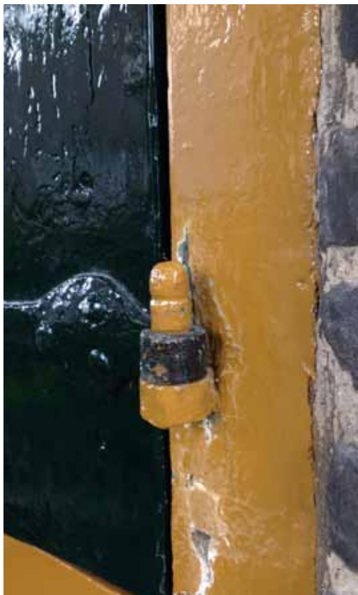
Links de appel-duim met vlak daaronder een deels nog zichtbare (houten) stop in het voormalige duimgat. Rechts de peerduim, altijd bovenaan
