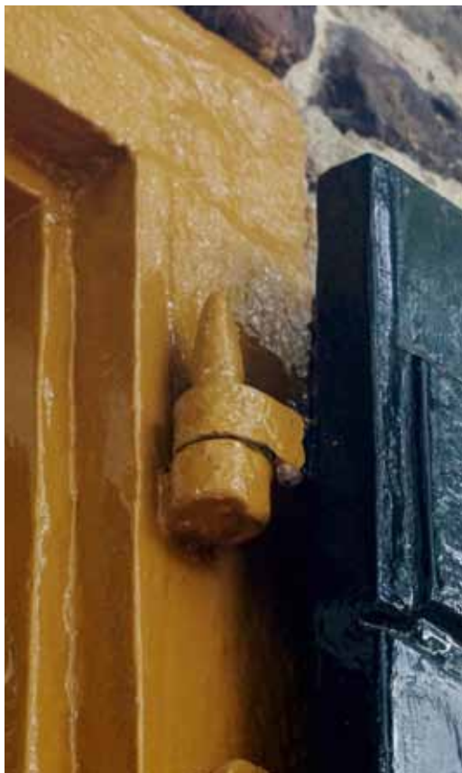
Links de appel-duim met vlak daaronder een deels nog zichtbare (houten) stop in het voormalige duimgat. Rechts de peerduim, altijd bovenaan
