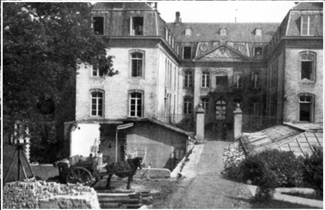
Voorbereiding tot de bouw van de kapel, 1935.
