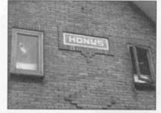
18. Zoals bij veel boerderijen die in opdracht van de familie Roelvink werden gebouwd, werd ook Honus voorzien van een naam op een gevelsteen, omgeven door siermetselwerk.
